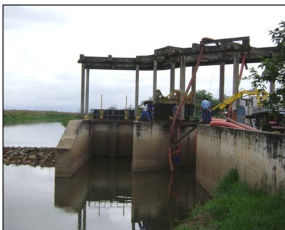
Foto 3 – Detalhe da barragem e da instalação das bombas
