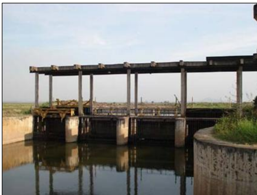
Foto 1 – Entradas na captação de água
