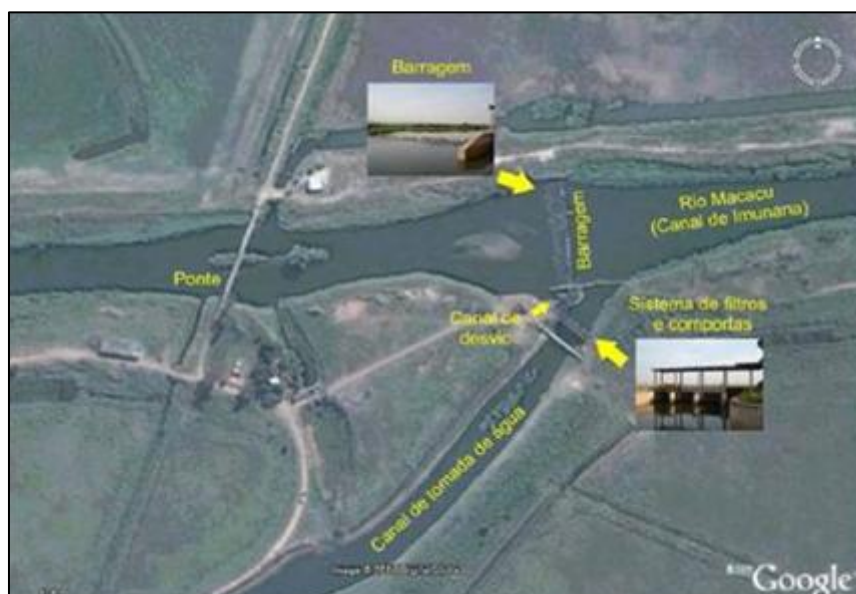
Figura 2 – Detalhe da captação de água da CEDAE no rio Macacu
