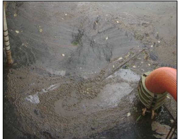
Foto 5 – Água de jusante da barragem sendo recalçada
