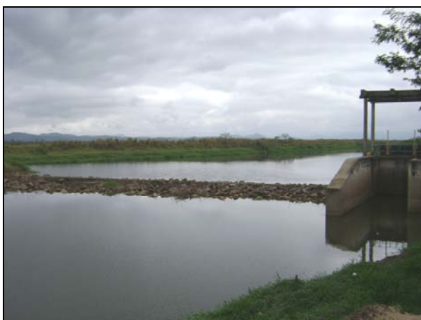
Foto 2 – Vista de jusante para montante da barragem de Imunana
